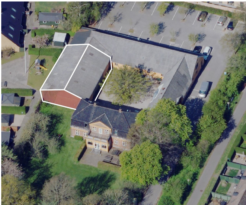
Skråfoto af Leragergård set fra øst. Laden, som må nedrives og genopføres, er vist med hvid streg.
